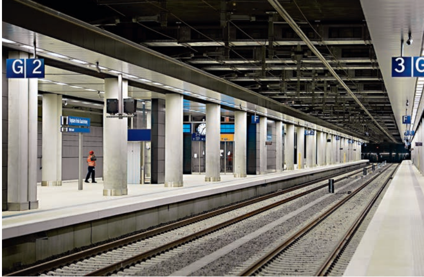
Unterirdischer Bahnhof am Airport BER: Künftig sollen auch Züge über die „Dresdner Bahn“ rollen
